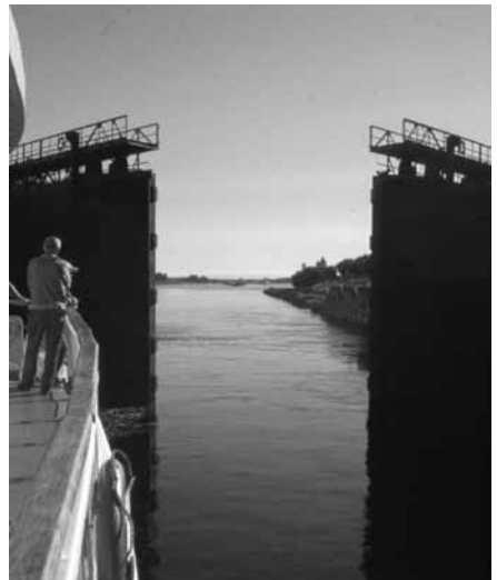
Schleuse im Moskau-Kanal
